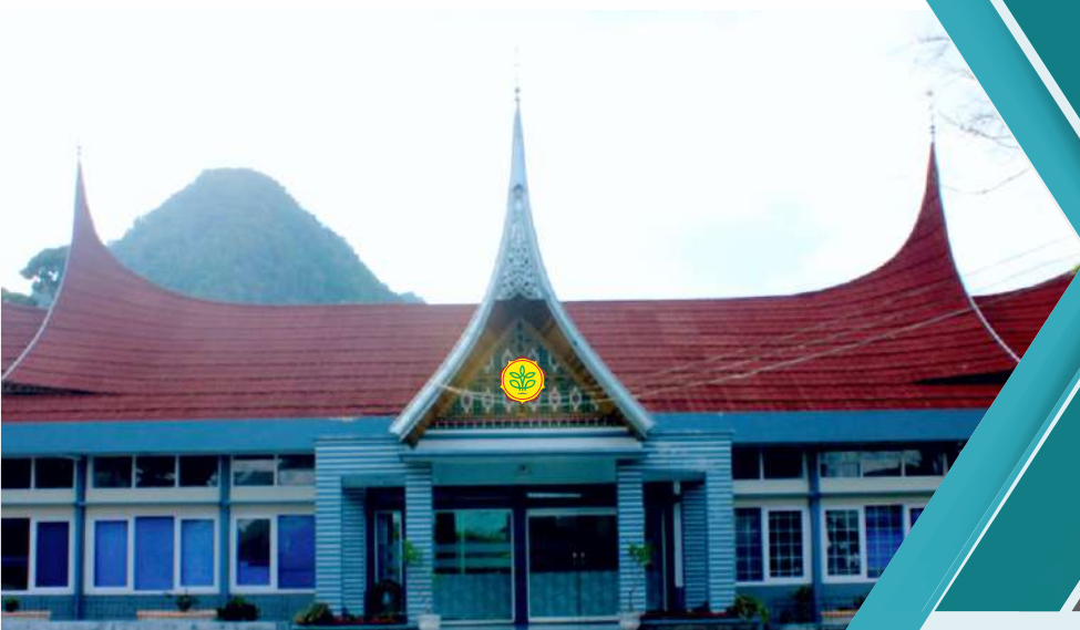
Balai Veteriner Bukittinggi
